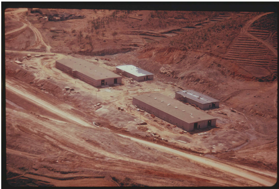
자료사진3 건설 중인 비활성탄약저장구역 1972년 13)
