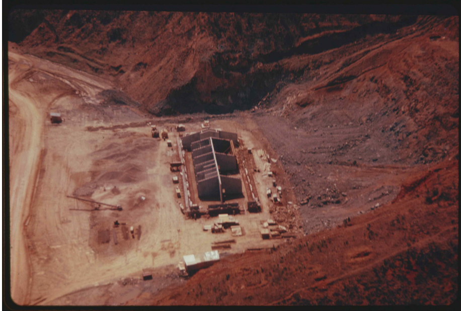
자료사진2 건설 중인 탄약정비공장 1972년 12)
