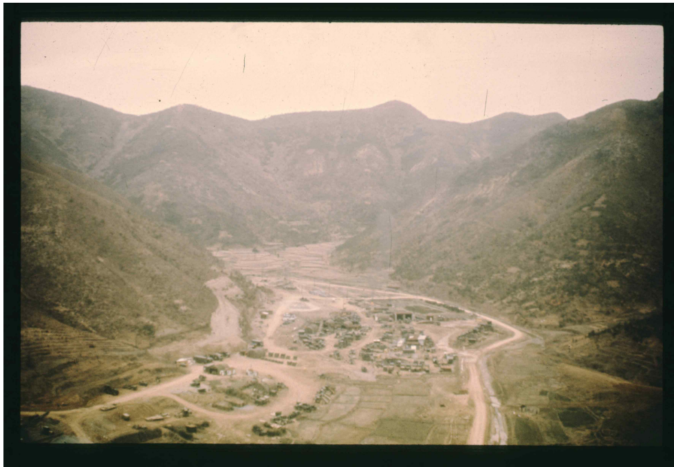
자료사진5 44공병대대가 춘산과 팔용산 사이 계곡부에 베이스캠프를 차린 모습 1972년 15)
